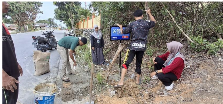
Gambar 6 : Pemasangan Pelang Papan Nama Jalan
