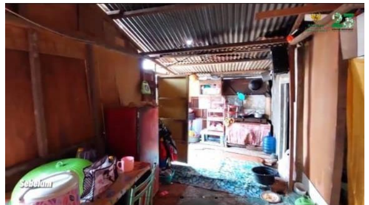
GAMBAR RUMAH SEBELUM DI REHABILITASI
