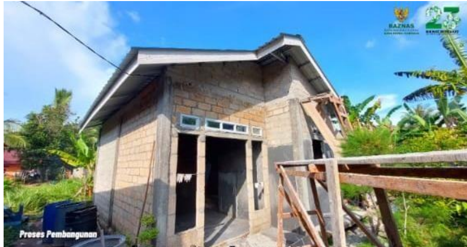
GAMBAR PROSES REHABILITASI RUMAH
