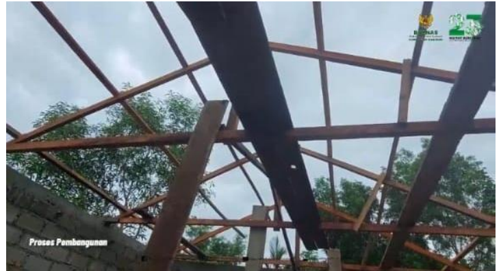
GAMBAR RUMAH DALAM PROSES PEMBANGUNAN
