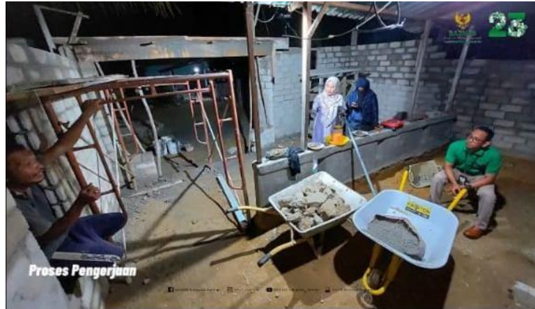
GAMBAR PROSES REHABILITASI RUMAH
