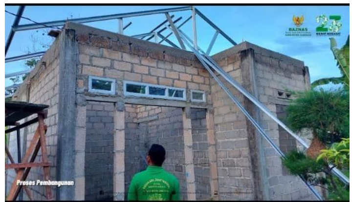
GAMBAR PROSES REHABILITASI RUMAH
