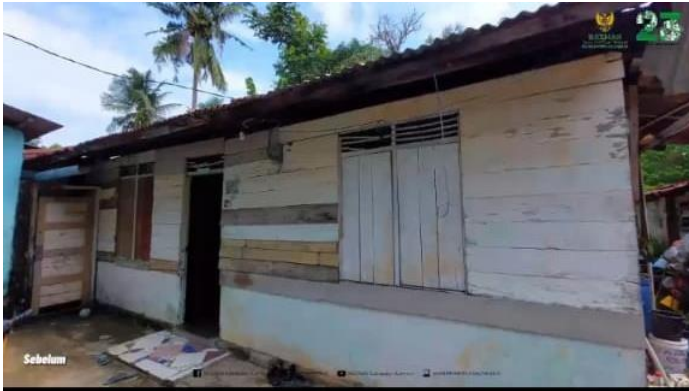
GAMBAR RUMAH SEBELUM DI REHABILITASI
