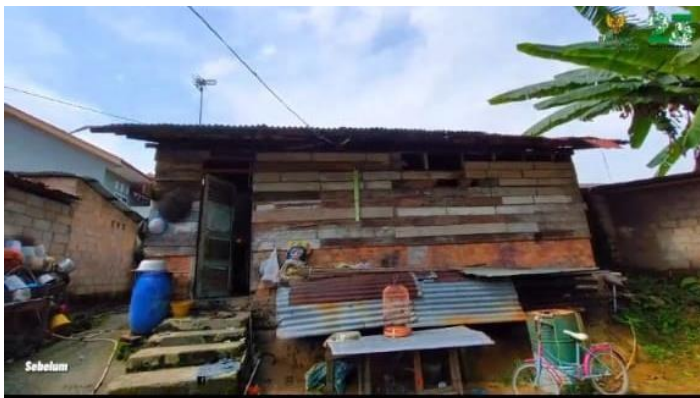
GAMBAR RUMAH SEBELUM DI REHABILITASI
