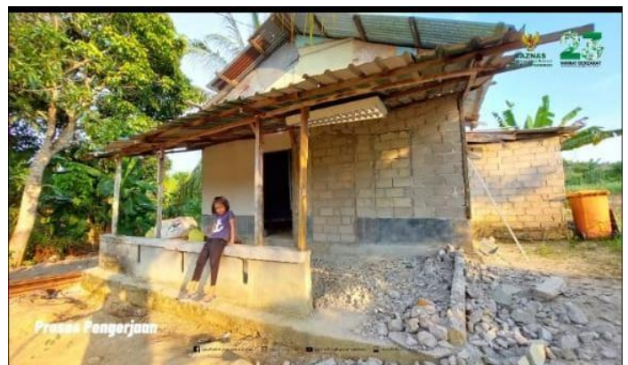
GAMBAR PROSES REHABILITASI RUMAH
