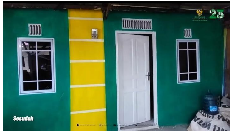
GAMBAR RUMAH SETELAH PROSES REHABILITASI
