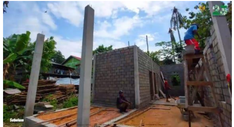
GAMBAR PROSES REHABILITASI RUMAH
