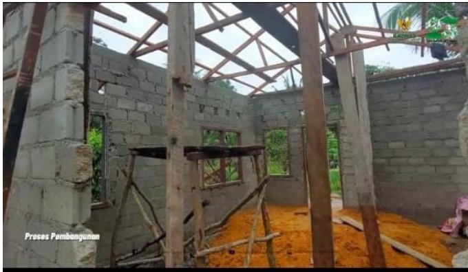
GAMBAR RUMAH DALAM PROSES PEMBANGUNAN
