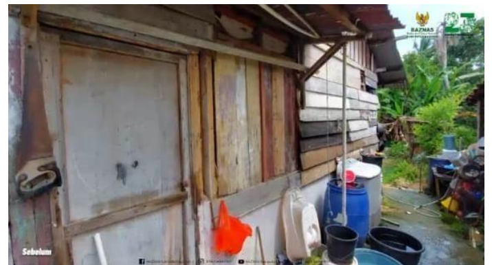
GAMBAR RUMAH SEBELUM DI REHABILITASI
