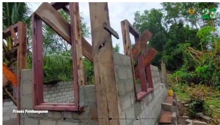
GAMBAR RUMAH DALAM PROSES PEMBANGUNAN
