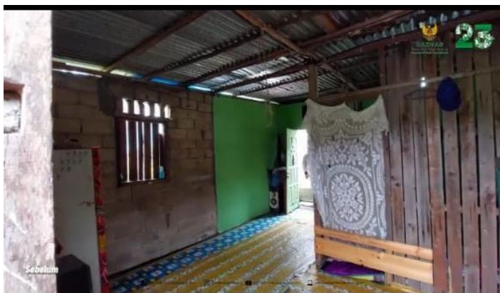
GAMBAR RUMAH SEBELUM DI REHABILITASI
