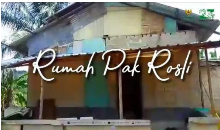
GAMBAR RUMAH SEBELUM DI REHABILITASI
