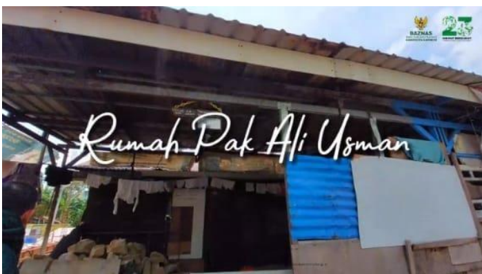
GAMBAR RUMAH SEBELUM DI REHABILITASI
